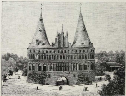
33. Das Holstentor in Lübed. Die Tortürme wurden von reichen Städten vielfach als Prunkbauten künstlerisch ausgestattet. Ein solcher Bau ist das aus dem 15. Jahrhundert stammende Holstentor in Lübed, das früher von anstreichenden Mauern eingefast war. Der umliegende Erdboden ist jetzt erhöht.
