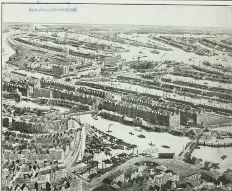
29. Panorama des Hamburger Hafens. (Nach der Hellogravüre des Bildes von Ernst Hemert. Betrag von der Grenze des Altonaer Gebietes mehr als 8 km zu beiden Seiten der Nordelbe stromaufwärts. Ihr oberer Wasserfläche allein 5 qkm. An den Kaiwänden und den im Wasser eingetragenen Pfählen („Tüddalben“) können baut, vor denen zahlreiche Kräne die Frachten aus dem Schiff in die Schuppen und umgekehrt heben. Der größte neuen Häfen und ihre großartigen Kai- und Speicheranlagen. Die Gesamtlänge der Kai- und Uferstreifen beträgt
