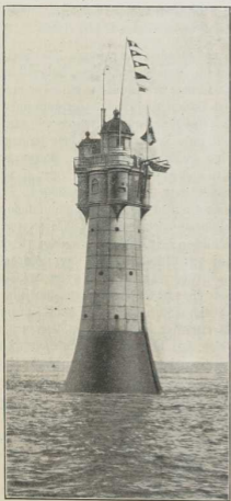
37 und 38. Der Rote Sand-Leuchtturm an der Wesermündung bei Bremerhaven und Durchschnittszeichnung davon. Der Leuchtturm ruht auf einem mit Mauereisen gefüllten eisernen Zylinder und wird durch eine Faschinenpackung von außen her gesichert. Der Turm besitzt ein festes Feuer, das alle Minuten durch einen stärkeren Lichtblitz von 5 Sekunden Dauer, das „Winkfeuer“, unterbrochen wird. Er beleuchtet einerseits die Wesereinfahrt, andererseits den Weg an Helgoland vorüber nach der Eidermündung.
