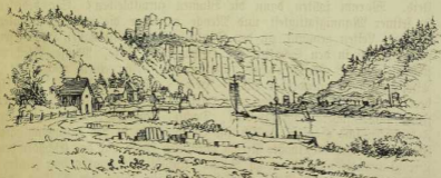
Schrammsteine, Postelmühle & Steinbrüche. gr. Winterberg.
