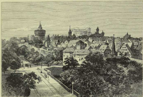
Der Franenthorgraben in Nürnberg. (Nach Photographie.)
