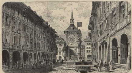
c. Strasse in Bern mit dem Zeitglockenturm. G. B. III, 59.
