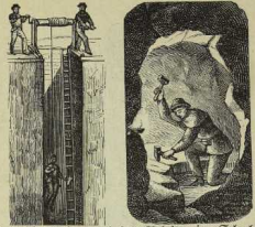
Das Hinabfahren und das Arbeiten im Schacht.
