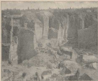
Plattenkalkbrücke in Solnhofen. (Atlas S. 67.)
