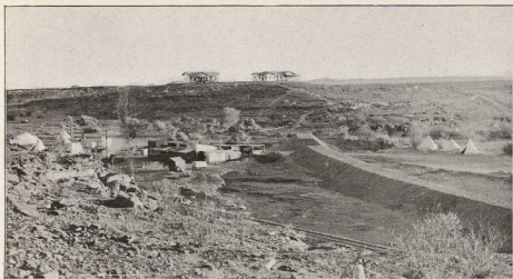
53. Bahnbau von Seeheim nach Kalffontein.
