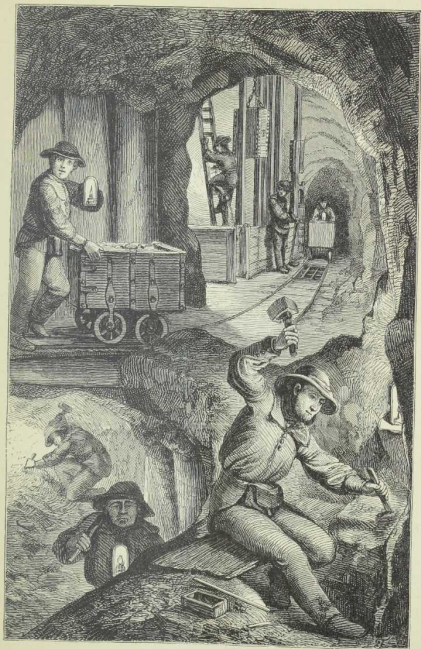
Inneres eines Bergwerks.
